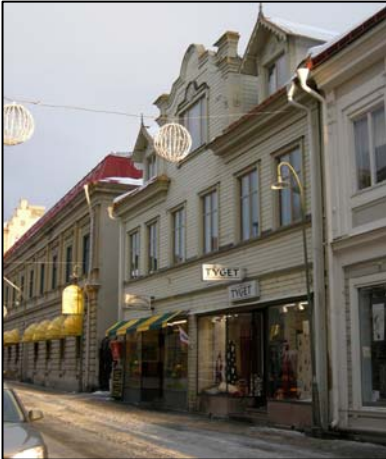
Över gården bakom denna 1880-talsfasad på Storgatan i centrala Östersund återfinns AC fr.o.m. den 1 februari.
